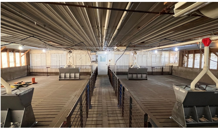
Tunnel Fan End
