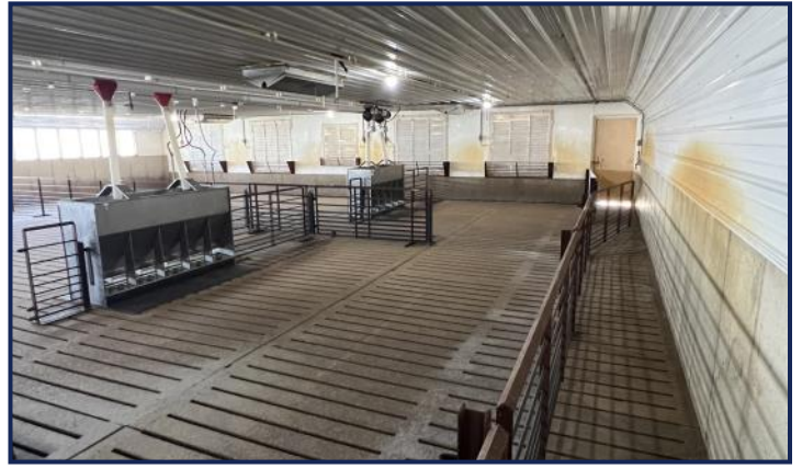
Tunnel Fan End
